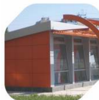
Выполнение интерьерных и облицовочных работ
